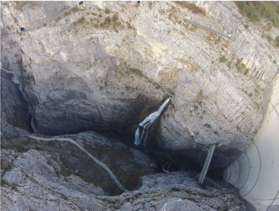
Foto 9: Foto aerea della forra del torrente Vajont con al centro la sezione dello scarico della galleria di sorpasso che scarica in alveo la portata naturale del torrente Vajont.
